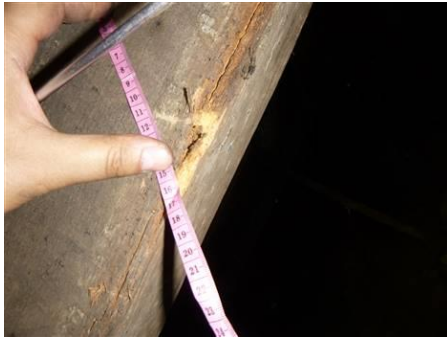
Photo n° PhTer007 Localisation : Toiture - Toiture 1; Toiture - Toiture 2; Toiture - Toiture 3 Ouvrage : Charpente (Bois) - Arbalétrier Parasite : Petites vrillettes ( Anobium punctatum ) Indices : altérations dans le bois, orifices obturés ou non (dégradation(s) faible(s)) Localisation sur croquis : 004
