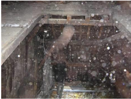
Photo n° PhTer006 Localisation : Combles - Combles 1 Ouvrage : Charpente (Bois) Parasite : Champignons de bleuissement Indices : décoloration du bois (présence étendue)
